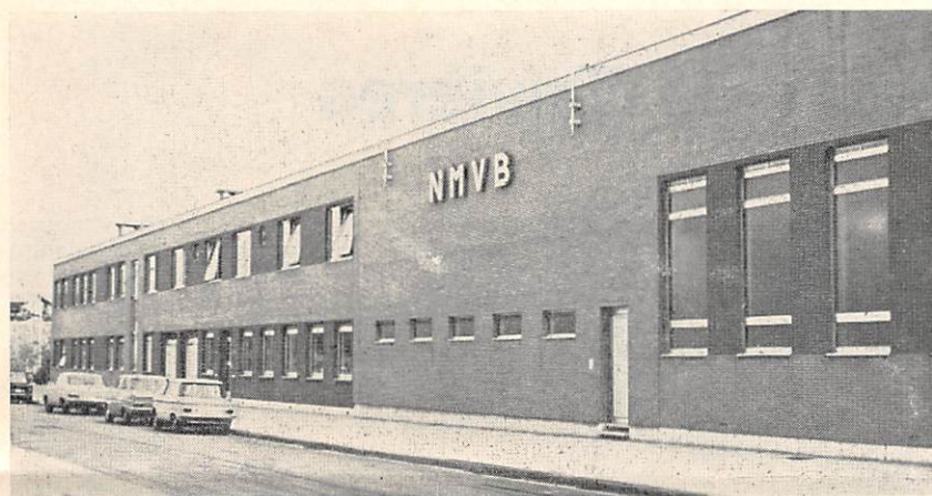
Vue partielle de la façade du bâtiment. A gauche, les bureaux et les appartements et à droite, une partie de l'atelier d'entretien.
